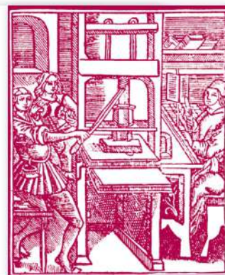
[FIG. 56] La imprenta de Gutenberg se accionaba manualmente, mediante una especie de tornillo largo que hacía subir o bajar una plancha de madera colocada sobre el papel, la cual ejercía presión sobre los tipos móviles embebidos en tinta.
